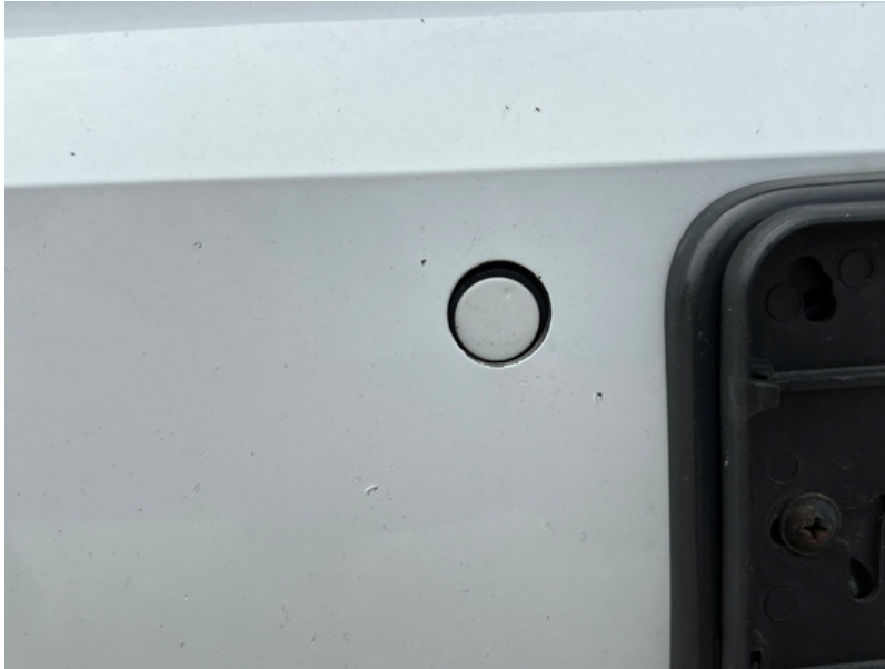
Stoßfänger verform, Sensor eingedrückt
